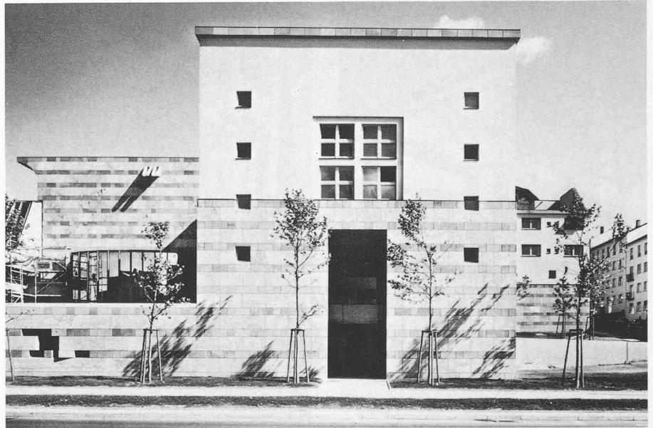
Die Boulevardfassade des Kammertheaters evokiert Postmoderne; eines von Stirlings Zitaten zu all den «-ismen» moderner Architektur
