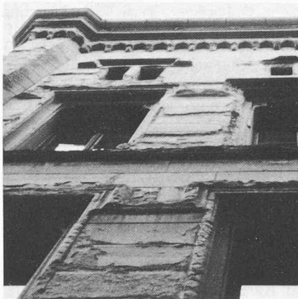
Bild 5a. Ist-Zustand vor Sanierung. Verwitterung
