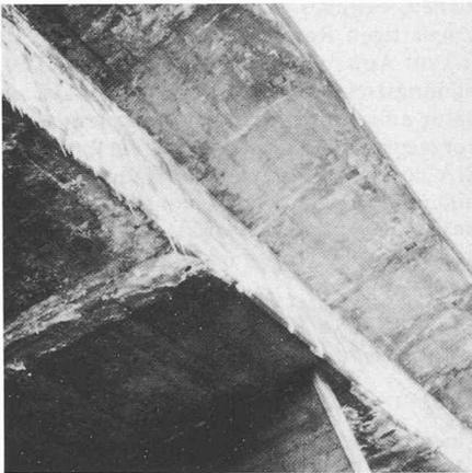
Bild 4a. Ist-Zustand vor Sanierung. Verwitterung und Korrosion
