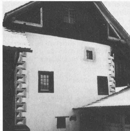
Bild 6b. Restaurierter Zustand nach Konservierung, Originalergänzung
