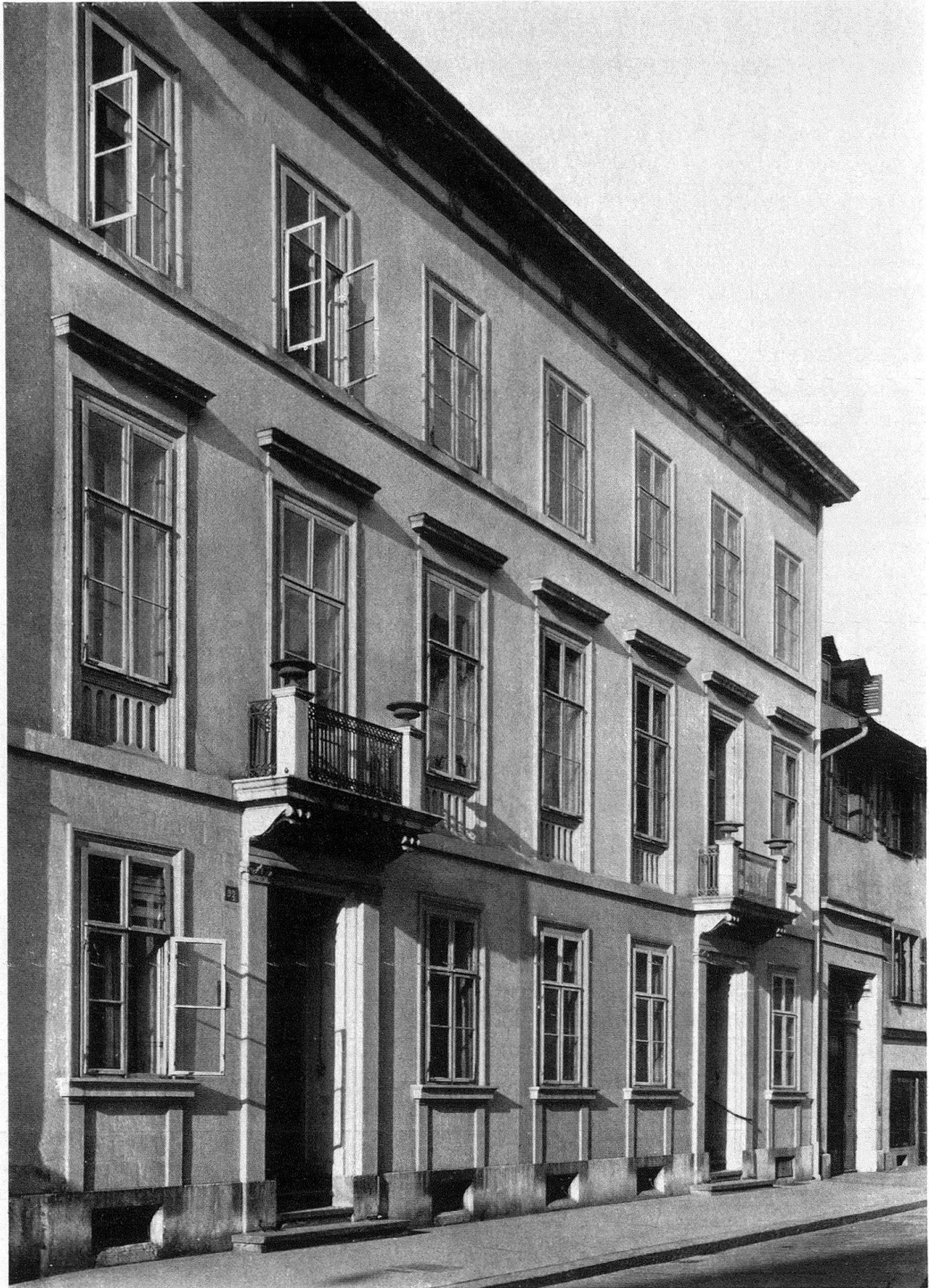
Basel, St. Alban-Vorstadt 90/92. Von J.J. Stehlin d. J. 1857 erbaut für Ratsherrn Carl Sarasin, heute bedroht durch das Projekt eines Verwaltungsneubaus
