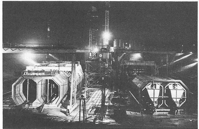
Bild 3. Herstellen von Tunnelteilstücken im Trockendock (Metro, Rotterdam)
