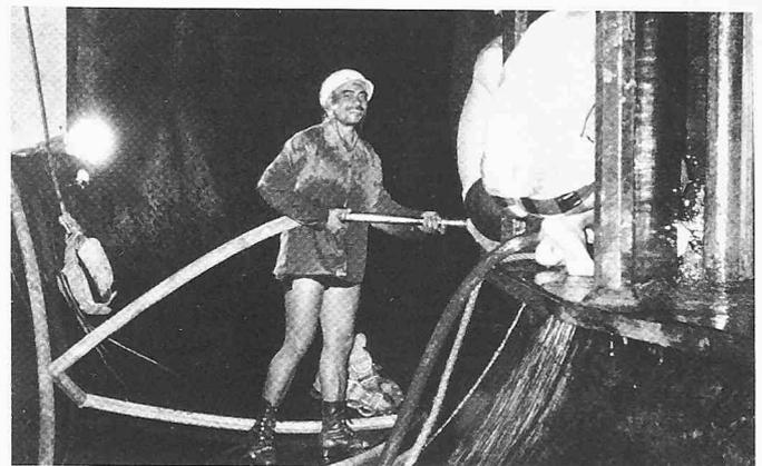
Bild 25. Arbeiten im Innern einer Francisturbine mit unzulässigen mobilen Beleuchtungseinrichtungen von 220 Volt; Einrichtungen mit Kleinspannung fehlen hier
