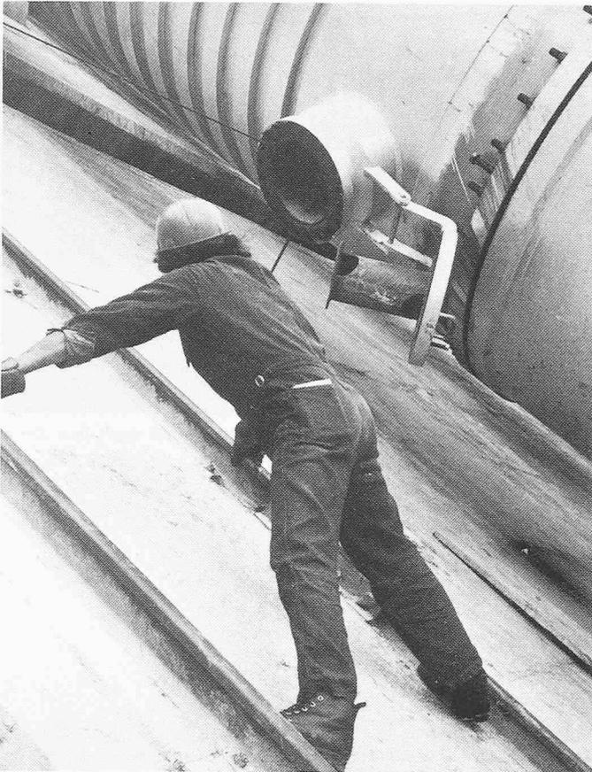
Bild 9. Auf diesem stark geneigten Druckleitungsstrasse fehlt ein horizontaler Zugang zum Mannloch und zur Expansion der Druckleitung, was durch ein Minimum an Koordination in der Projektierung und Bauausführung hätte erreicht werden können
