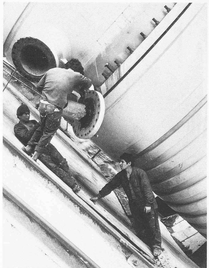
Bild 10. Das Ein- und Aussteigen durch dieses ohnehin zu enge Mannloch ist hier besonders schwierig. Ein gefahrloses Arbeiten an der Druckleitungsexpansion (z. B. Nachziehen der Schrauben über den ganzen Umfang oder Auswechseln der Dichtungsschnüre) ist unmöglich
