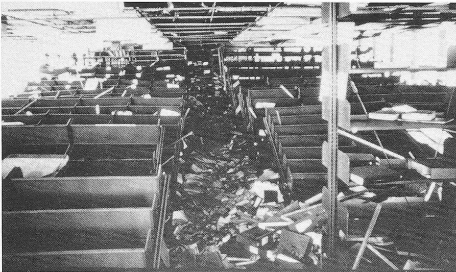
Bild 3. Bibliothek nach einem Erdbeben. Die Schäden im Innern von Bauwerken konventioneller Ausbildung übertreffen oft die Schäden am Bauwerk
