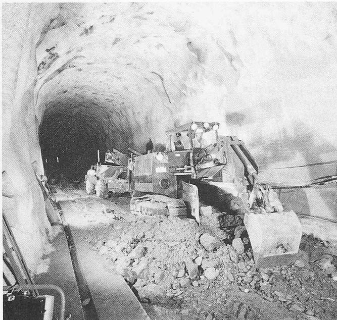
Bild 18. Bahnunterbau. Filterkies und Mitteldrainage. Eingewalztes, zementstabilisiertes Ausbruchsmaterial
