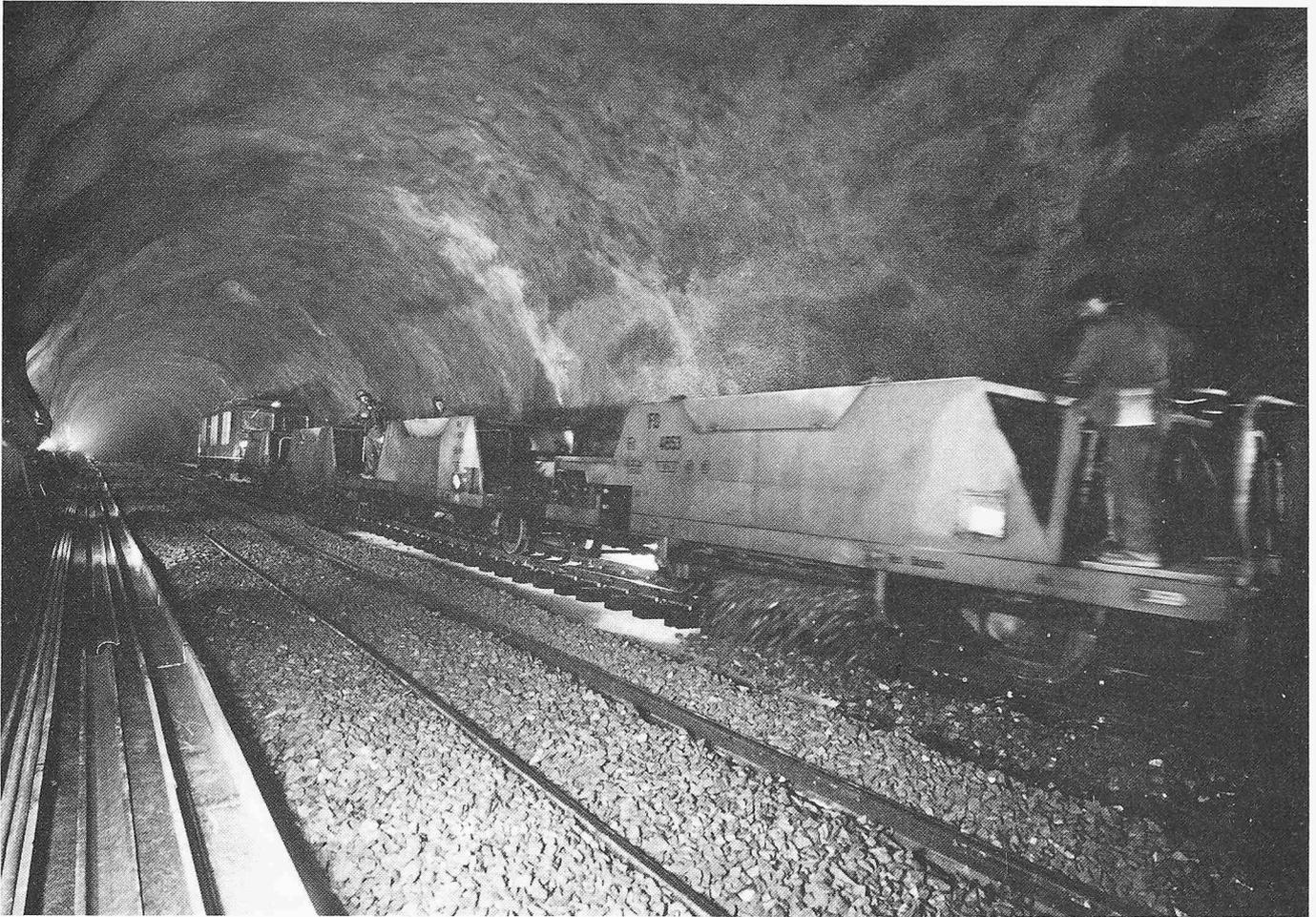
Bild 19. Schotterzug in der Kreuzungsstelle Tunnelstation Rotondo
