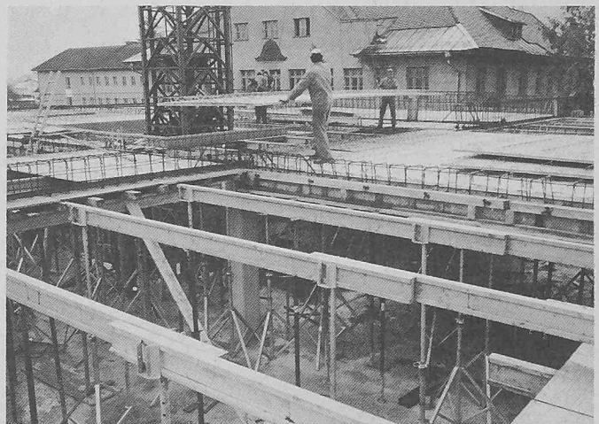
Bild 1. Fertigteildecken mit System Dokaflex 20
