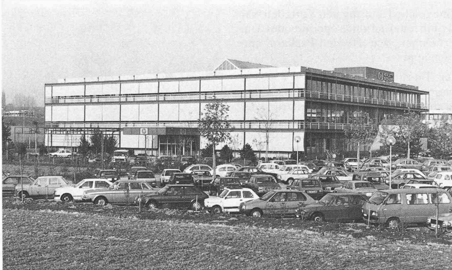
Bild 2. Südwestfassade mit geschlossenen Storen vor den Laufstegen
