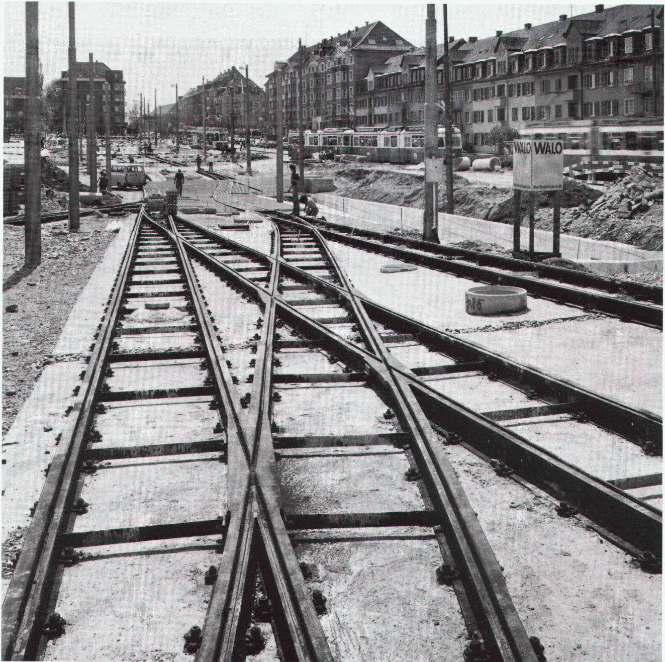
Totalumbau der Geleiseanlage Hirschwiesenstrasse, VBZ, Zürich
