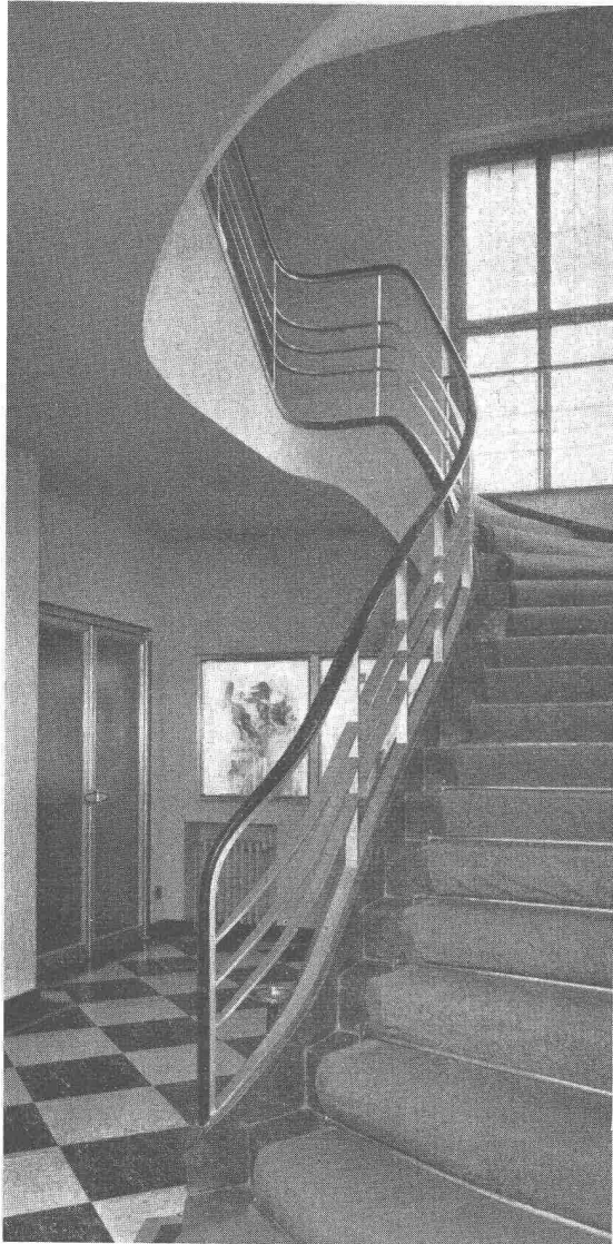
Geländer in Altenrhein eloxiert
