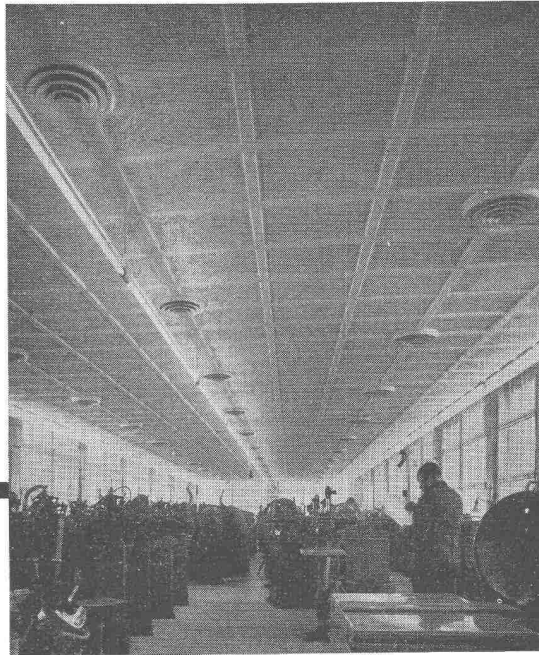
Klimaanlage «System Häusler» in Uhrenfabrik
