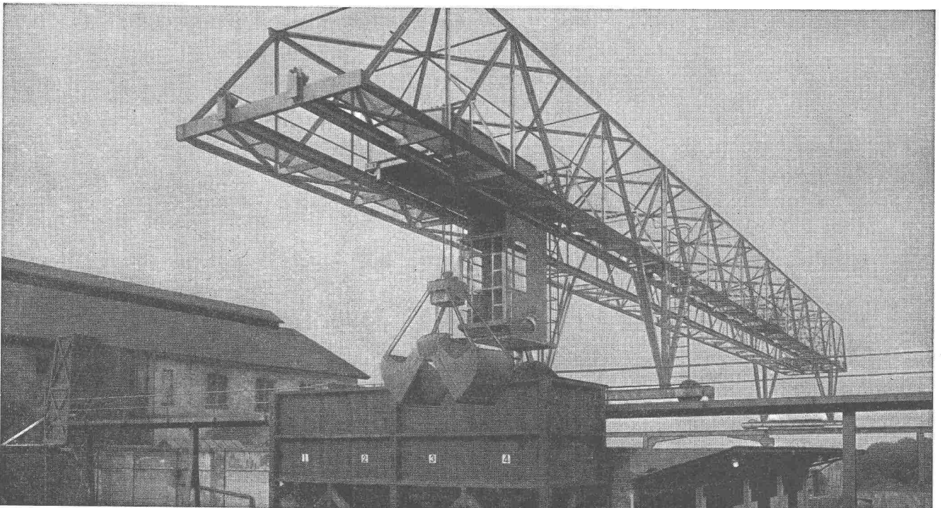
Verladebrücke in Schweisskonstruktion 2,5 t Tragkraft, 46 m Länge
