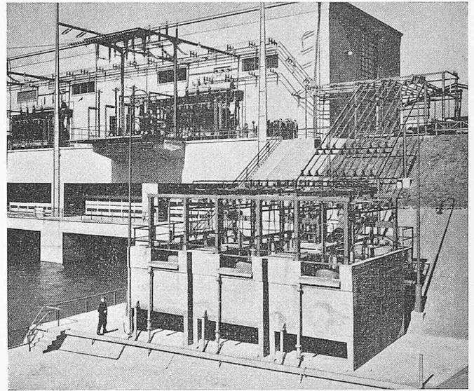
Bild 4. Anordnung der drei Wasserwiderstände im Kraftwerk-Albruck-Dogern
