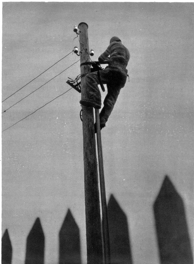
Auch zur Aufstellung der elektrischen Freileitungen braucht es Männer, die gerne zwischen Himmel und Erde verweilen
