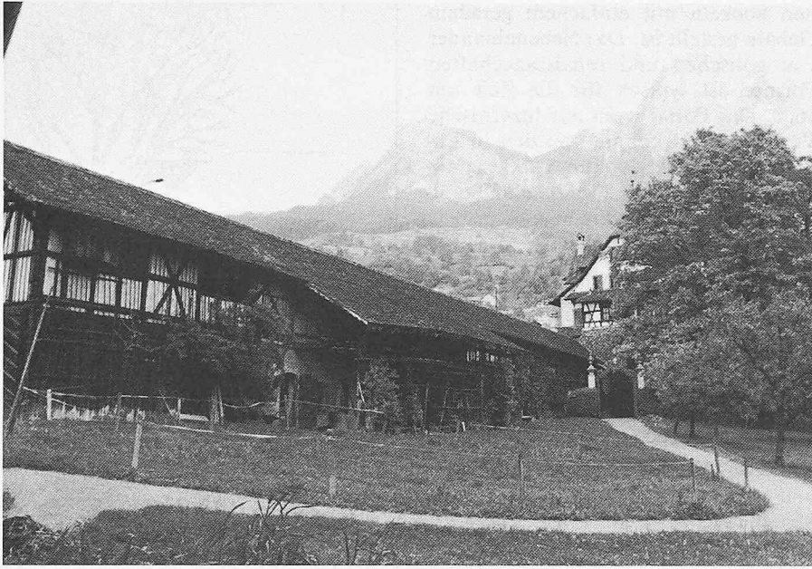
Ökonomiegebäude von Südwesten
