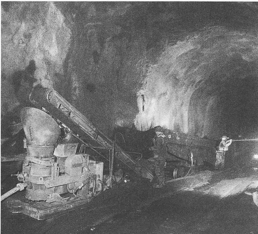
Bild 9. Spritzbetonmaschine, Beschickungsförderband und Bunkerzug mit Trockengemisch
