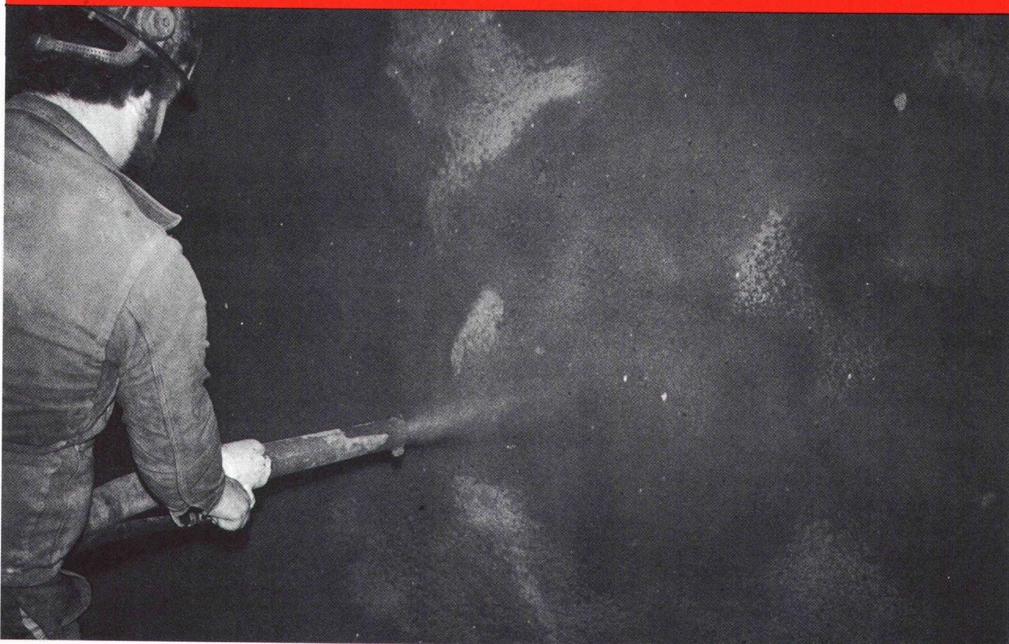
SILIPON SPR6 (ST) ist ein Betonzusatzmittel, das den Staubanfall im Düsenbereich bis zu 95% verringert.
