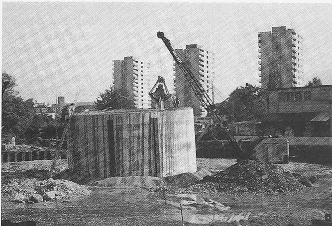
Bild 4. Senkbrunnen im Zentrum eines der neuen Vorklärbecken (Los 2)
