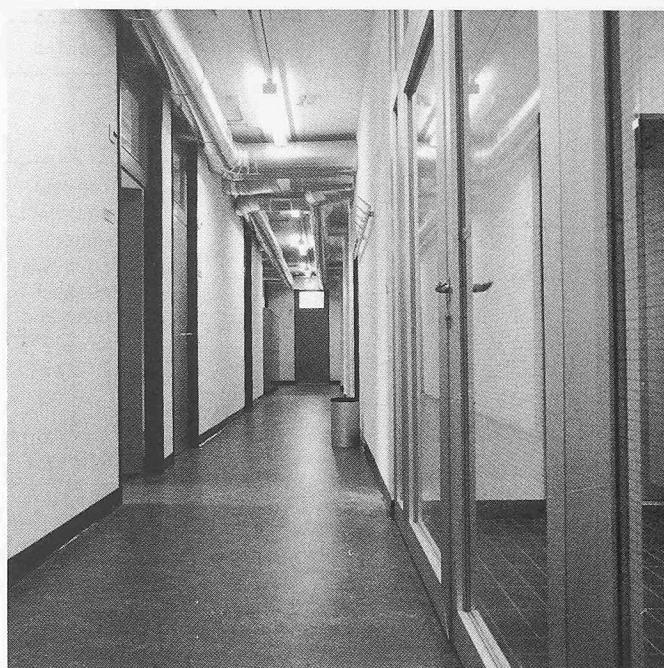
Bild 3. Sichtmontage der Zu- und Abluftrohre und Lichtinstalltionen
