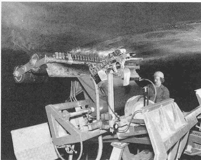
Bild 3. Los West: Aufkleben der Gewölbeisolation auf das Tübbingaussengewölbe
