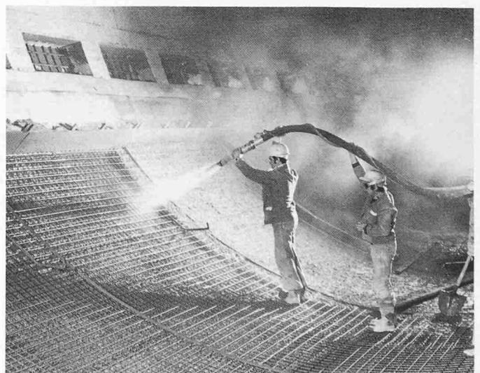
Bild 4. Los West: Erstellen des Spritzbetonsohlgewölbes
