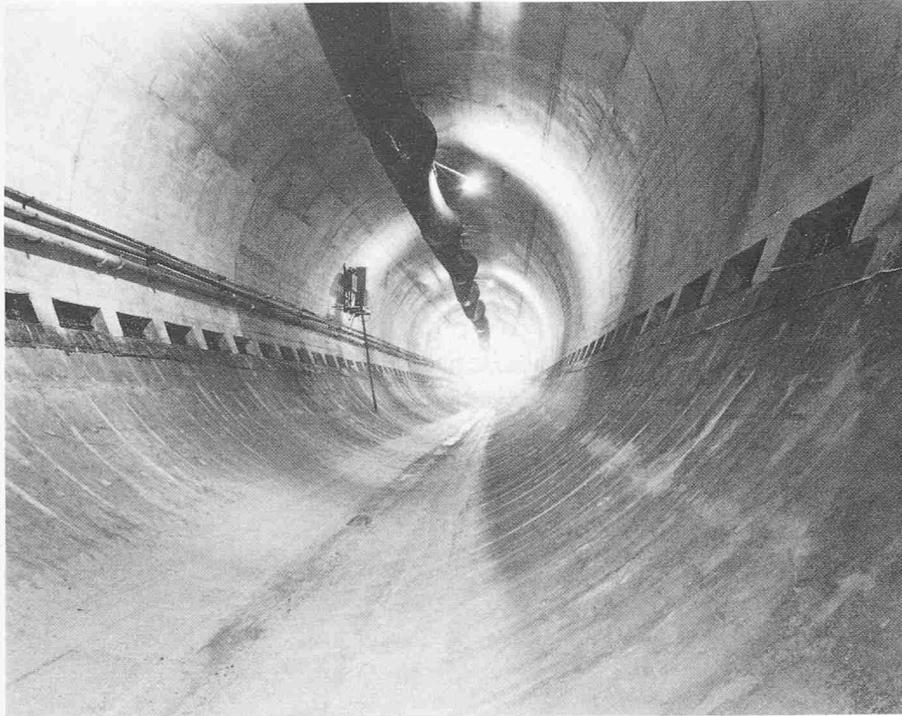
Bild 5. Los West: Der Kieskoffer ist entfernt; mit der Abdichtung der Tunnelsohle kann begonnen werden
