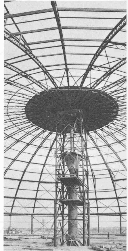
Bild 8. Montage mit Hilfe des Turms
