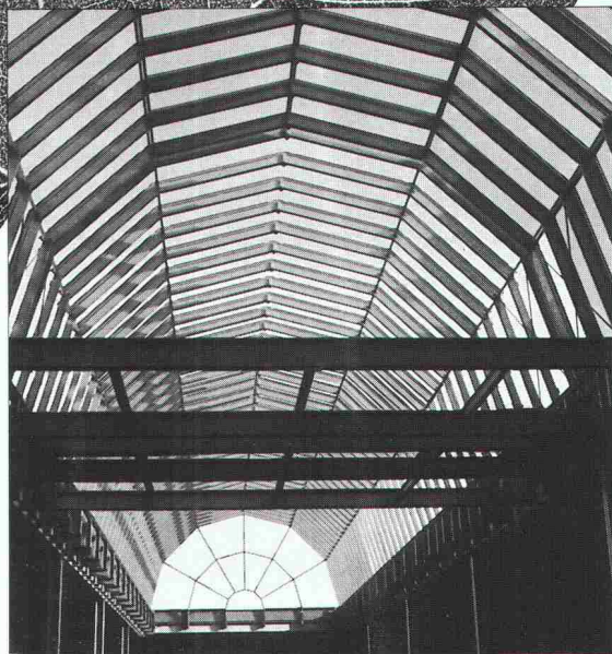
Stahl- und Industriebau
