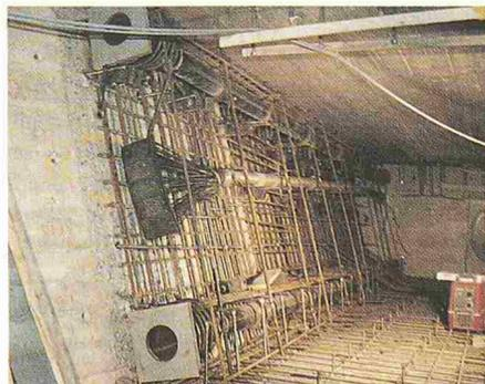
Bild 10. Brückentrog-Verstärkung, Vorspannung und Armierung
