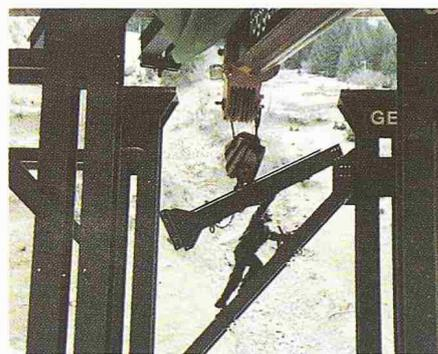
Bild 9. Montage der Querverstrebungen
