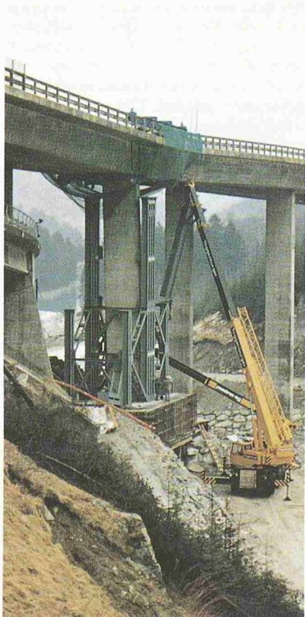
Bild 8. Montage des Stahlgerüsts mit Pneukran ab Baupiste linkes Reussufer
