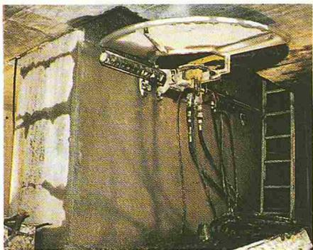
Bild 13. Bohr- und Fräsarbeiten am Pfeilerfuss für den Einbau des Gleitlagers
