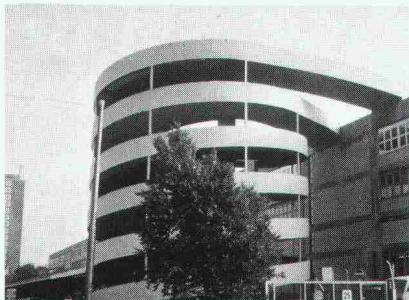
Rampe Parkhaus Migros Herdern
