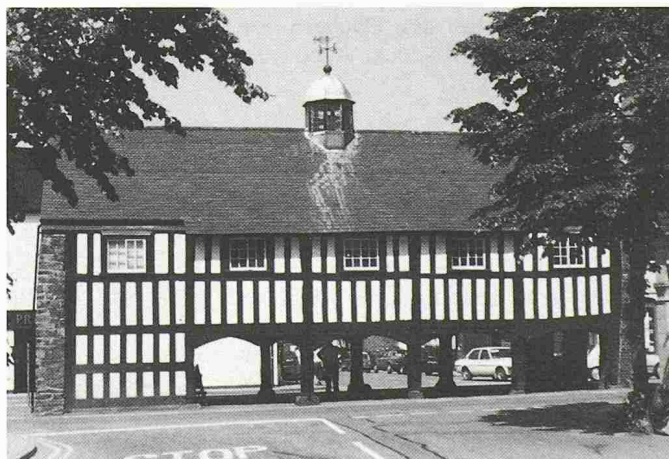
Llanidloes. Letzte überdeckte Markthalle in «schwarzweiss» Fachwerk, 16. Jhdt.
