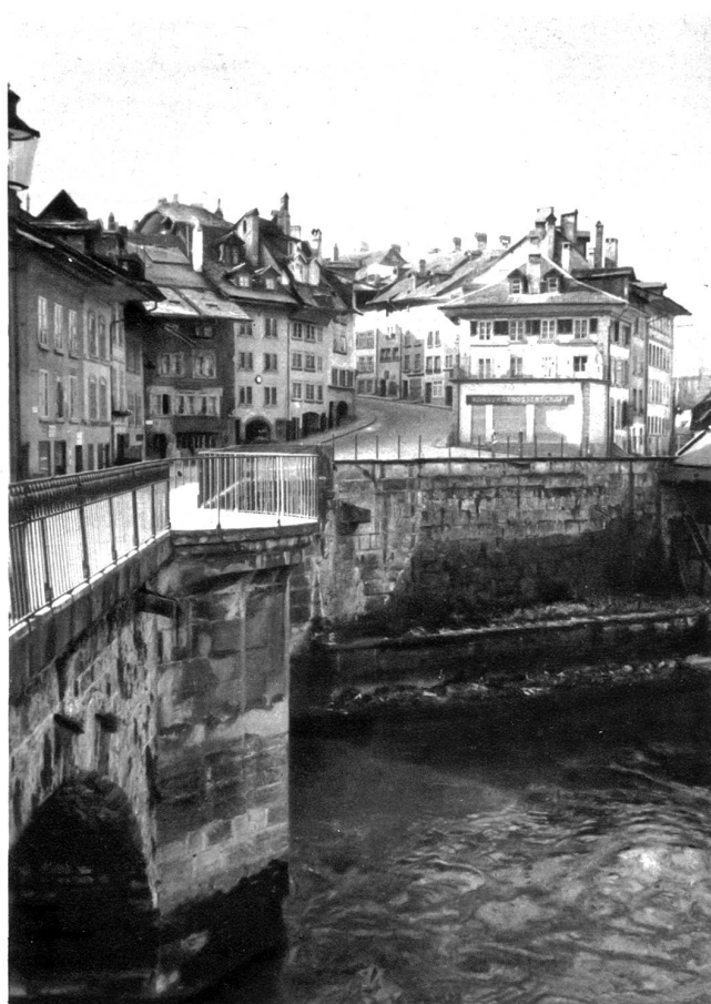
Nydegghbrücke mit Läuferplatz und Stalden
