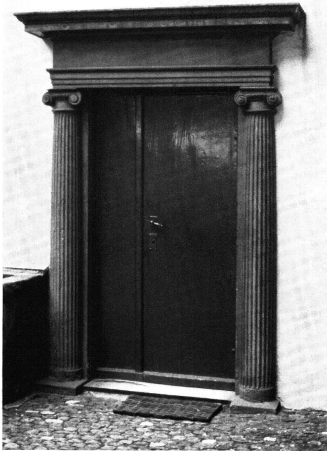
Abb. 12 Basel, Spießhof, Portal zum linken Annexbau
