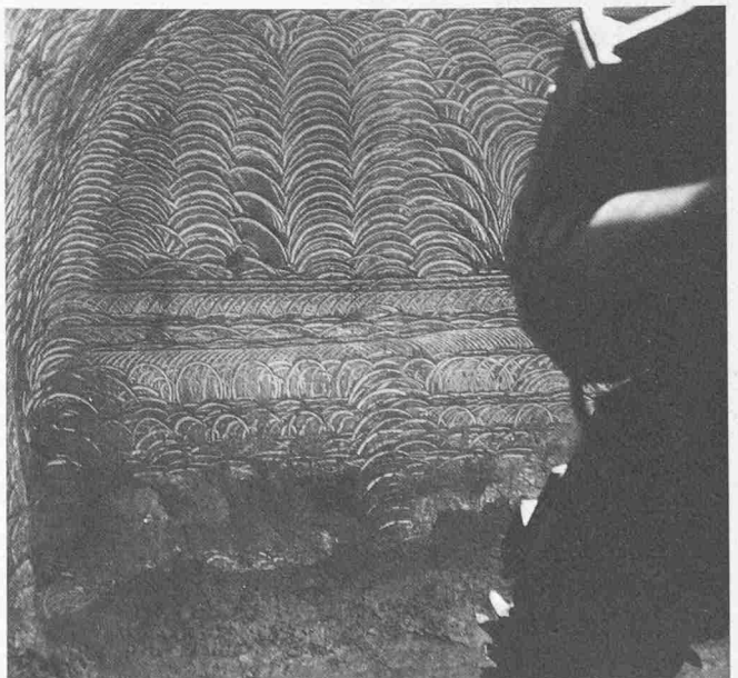
Bild 23. Gefräste Vortriebsbrust im Molassefels des Entlastungsstollens
