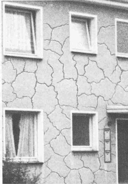
Kondenswasser bildet. Bei Sonnenaufstrahlung wird dann das sich hinter der Putzschicht befindliche Kondensat verdampfen. Es entstehen unterschiedliche Spannungen innerhalb der Putzschicht oder an den Grenzschichten. In den Wintermonaten besteht die Gefahr der Eisbildung und Abspaltung des Putzes durch die Volumenvergrößerung des gefrorenen Wassers.
