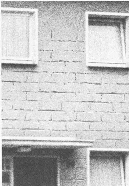
Bild 3. Spannungsrisse
