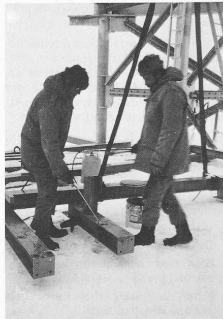
Bild 15. Stahlbaumonteur mit Windjacke und Pelzmütze (statt Bauhelm)
