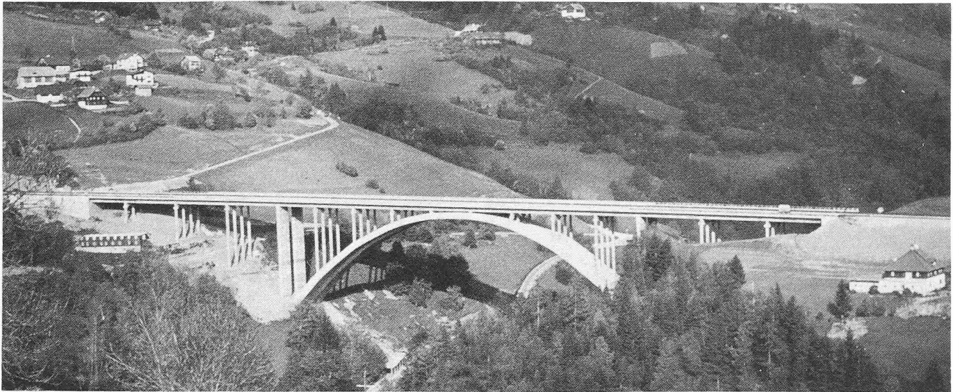
Bild 4. Bogenbrücke mit 167 m Spannweite für den Talübergang L26 Leobengraben für die Tauernautobahn im Liesertal in Kärnten
