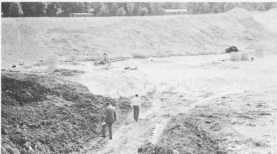
Bild 1. Deponie für entwässerten, mit Kalk verfestigten Schlamm in München-Grosslappen
