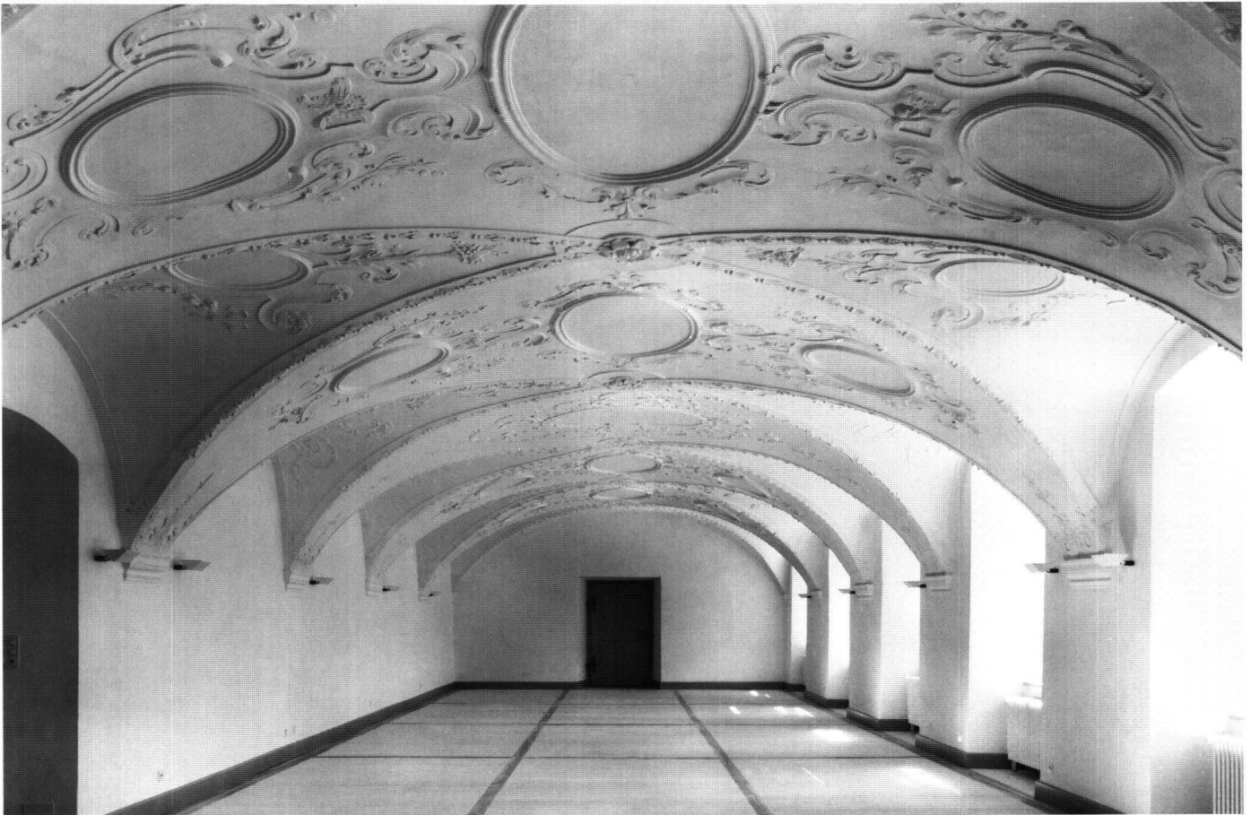
Abb. 10: Einsiedeln, Kloster, ehemaliger Kapitelsaal. Zumindest die vier westlichen Joche des ehemaligen Kapitelsaals gehören zu den ältesten stuckierten Räumen der barocken Klosteranlage.
