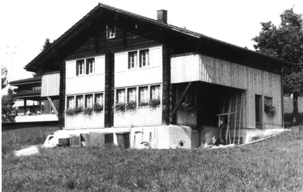
Abb. 9: Tuggen, Haus Bollenbergstrasse 14. Anhand der axialsymmetrischen Fenstereinteilung lässt sich ablesen, dass das kleine Haus von Anfang an in zwei Hälften aufgeteilt war, die unabhängig von zwei Familien bewohnt wurden. Die Vertäferung an der Hauptfront ist eine Zutat des 18. Jahrhunderts.
