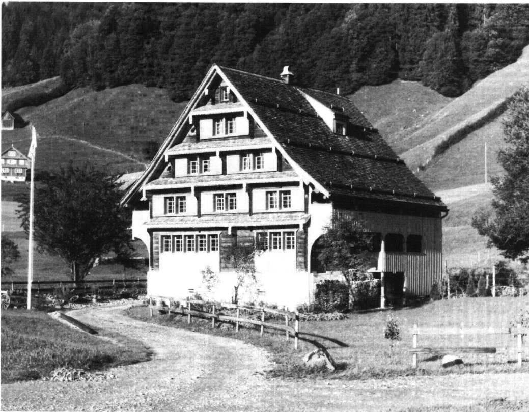
Abb. 14: Einsiedeln, Haus Steinbach, Euthal. Das Bauernhaus im Steinbach mit Baudatum 1812 gehört zu den markantesten Holzbauten im Bezirk Einsiedeln. Trotz der späten Erbauungszeit besitzt das Bauernhaus noch zahlreiche traditionelle Elemente des 17. und 18. Jahrhunderts.
