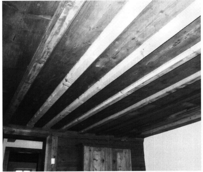
Abb. 8: Altendorf, Haus Steinegger, Hafengeweg 2. Von der Holzdecke der Stube im 1577 geschaffenen Hausteil waren genügend Elemente vorhanden, dass sie wiederhergestellt werden konnte. Die Decke war allerdings derart geschwächt, dass sie auf einen neuen Träger montiert werden musste.
