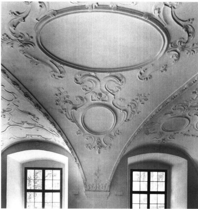
Abb. 12: Einsiedeln, Kloster, ehemaliger Kapitelsaal. Die Stuckaturen des frühen 18. Jahrhunderts waren unter den bis zu zehn Überfassungen hervorragend erhalten. Hingegen fanden sich nicht die geringsten Hinweise auf eine Buntfassung, so dass angenommen werden muss, dass die Stuckaturen von Anfang an weiss gefasst waren.
