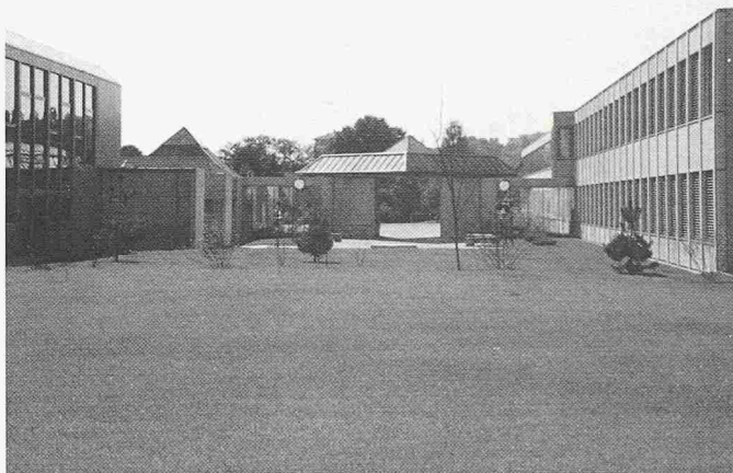
Ecole polytechnique fédérale de Lausanne, Ecublens; maître d'ouvrage: Conseil des EPF, Lausanne; architectes: Zweifel + Strickler + associés, Lausanne-Ouchy
