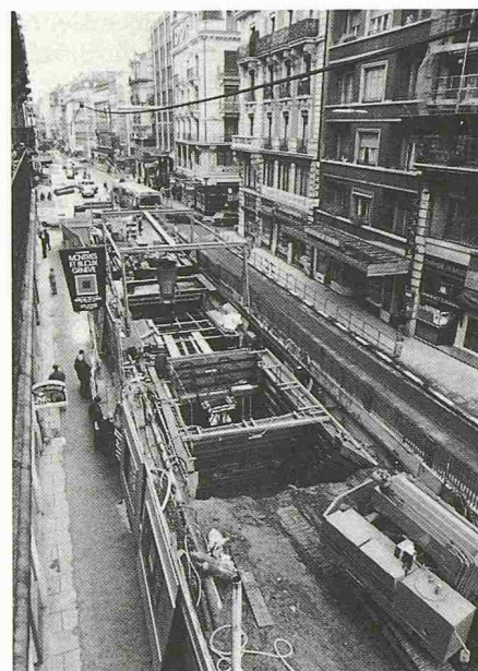
Bild 4. Bau eines Leitungskanals in einer Geschäftshauptstrasse unter Aufrechterhaltung des öffentlichen Verkehrs und Gewährung des freien Zugangs zu den Geschäftseingängen
