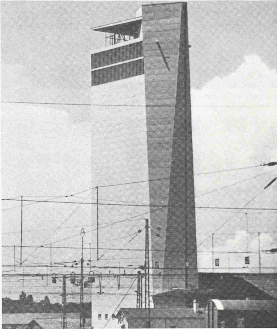
Silo de l'UCAR à Renens (1959); hauteur: 61,7 m (avant son agrandissement).
