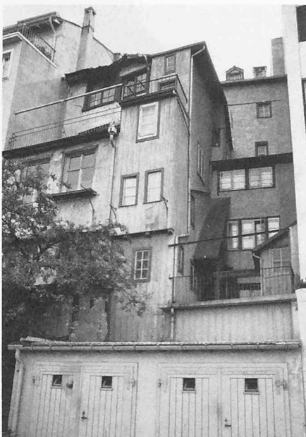
Rheinfassade, vor der Sanierung
