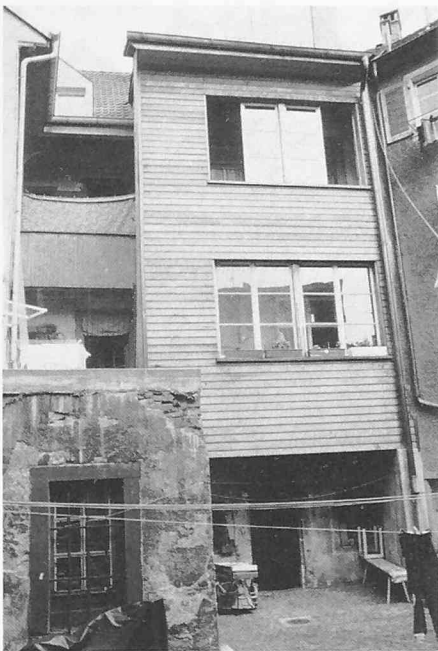
Rheingasse 69, Hoffassade, vor der Sanierung
