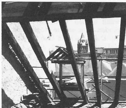
Auch bei den Dachstühlen wurde versucht, möglichst viel der vorhandenen Substanz zu retten
