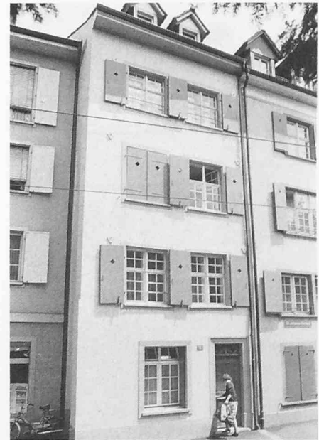
Strassenseite nach der Sanierung
