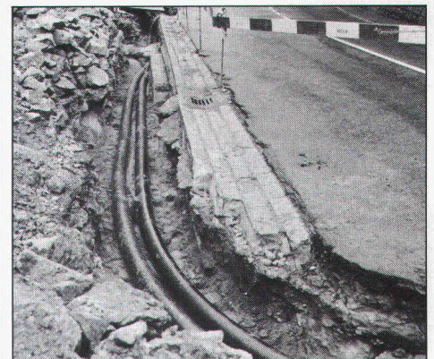
11.55 Komplett verlegt – 360 m nahtlose Fernwärmeleitung – Ziel erreicht!
