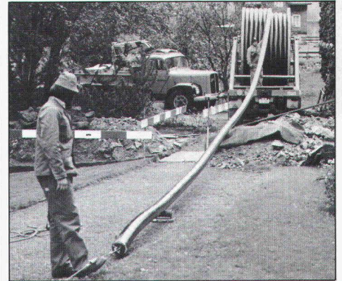
10.04 Die Verlegung der FLEXWELL-Leitung beginnt...
