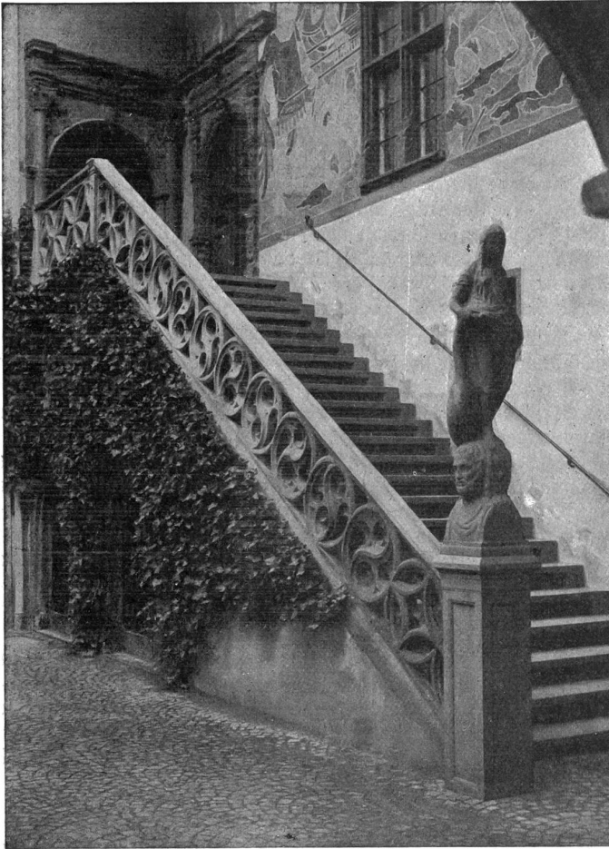
Rheinfelden, Rathaus. — Freitreppe im Hof.
