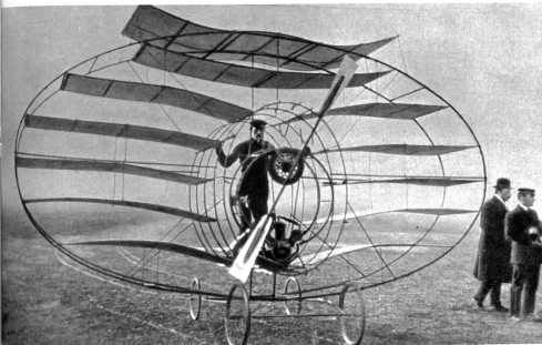
Wie ein phantastischer Ozeansegler wirkt der Vieldecker des französischen Flugzeug-Konstrukteurs Doret . Der Erbauer des Flugzeugs glaubte, dass es sich durch die grosse Zahl der Tragflächen leichter in die Lüfte erheben würde. Er täuschte sich: Die Maschine ging 1909 beim ersten Flugversuch nicht in die Höhe, sondern — zu Bruch
