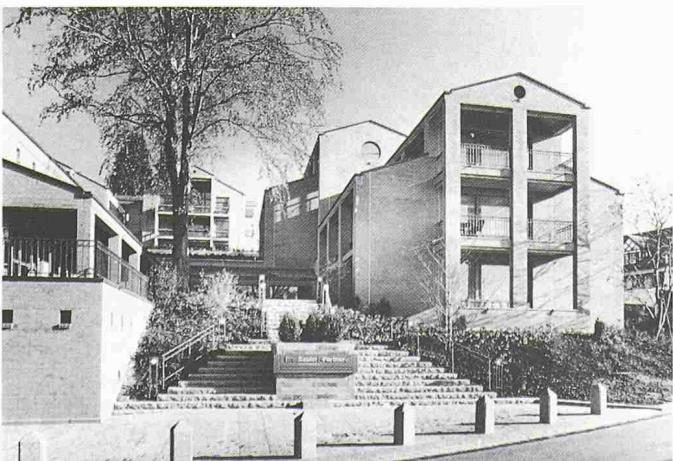
Bild 7. Eingangspartie an der Zollikerstrasse
