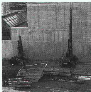
Modernste Bohrmaschinen beim Ausführen der Hochdruck-Injektionswand
