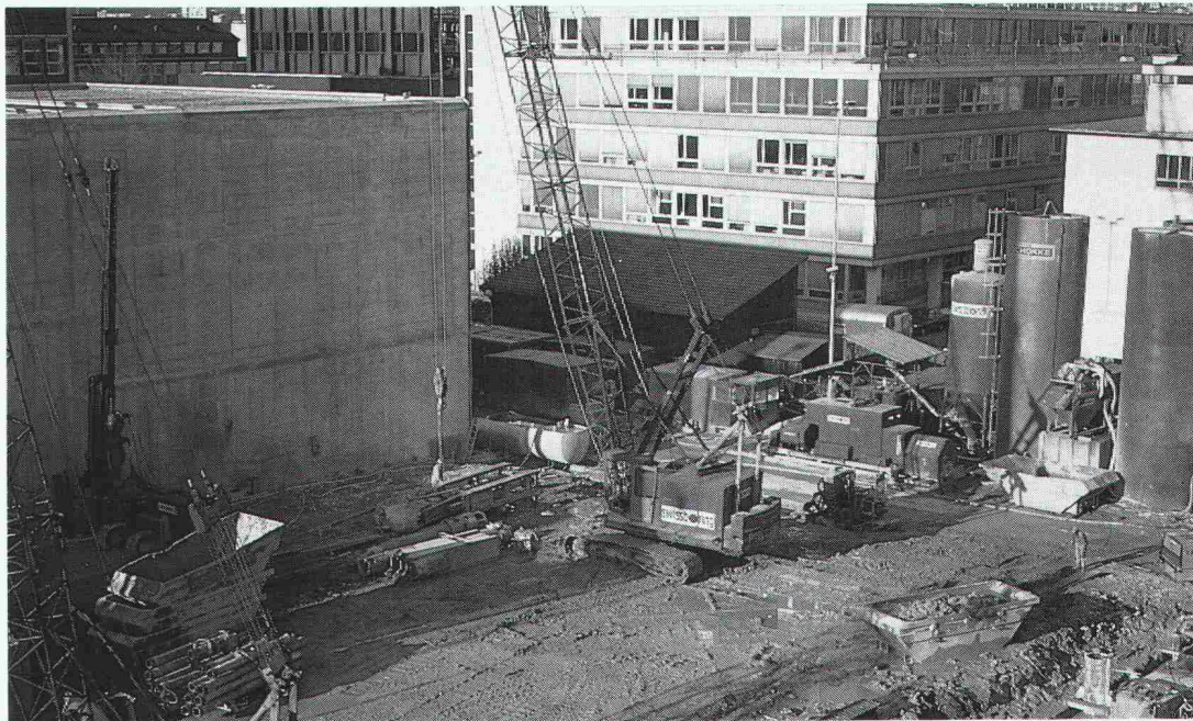
Flur Süd, Zürich. SBG-Neubau Energiezentrale
