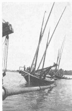
Fig. 7. Tronçon de conduite en voie d'immersion.
