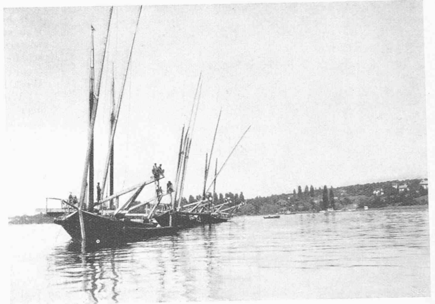
Fig. 2. Les trois barques de pose.
