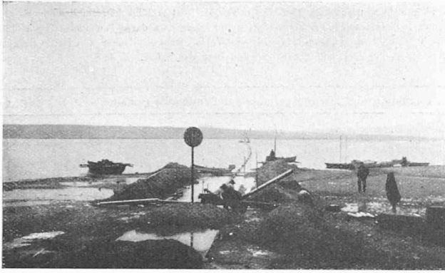
Abb. 3. Die schwimmend verlegte Leitung vor deren Versenkung.
