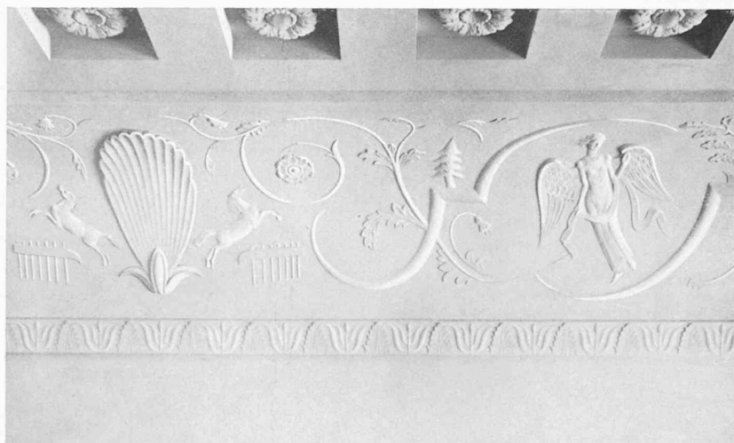
KEHLE UND DECKEN-DETAIL AUS DER AULA
