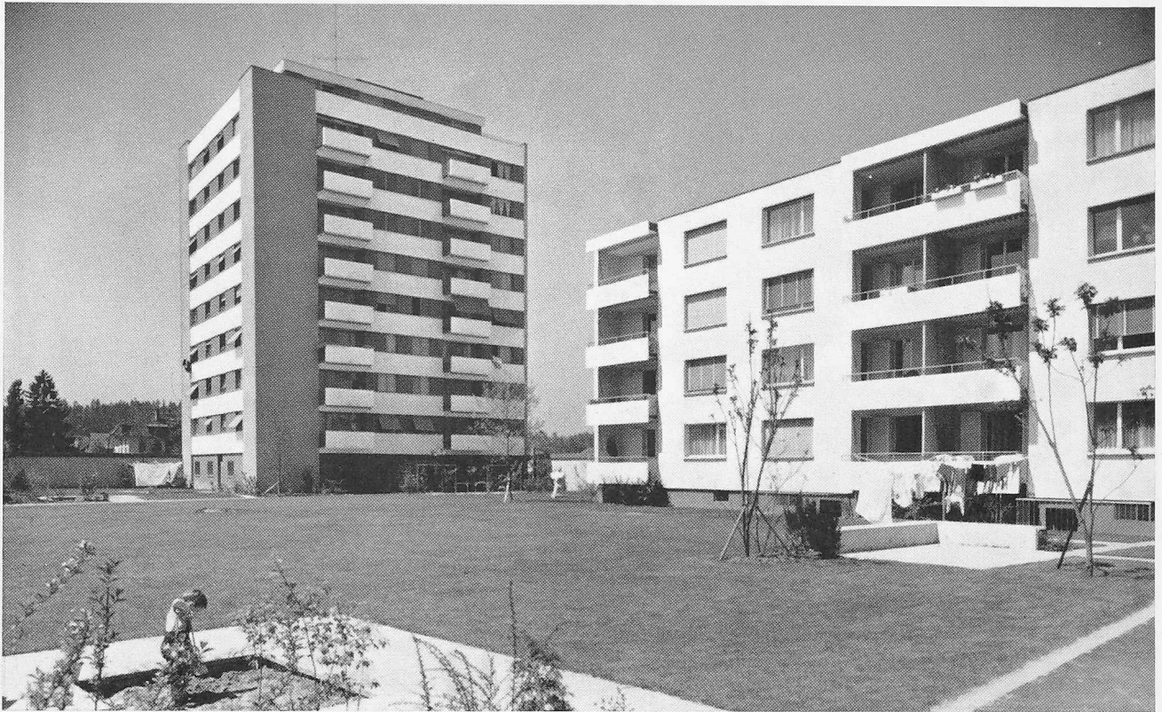
Bebauung an der Henzmannstrasse aus Osten
