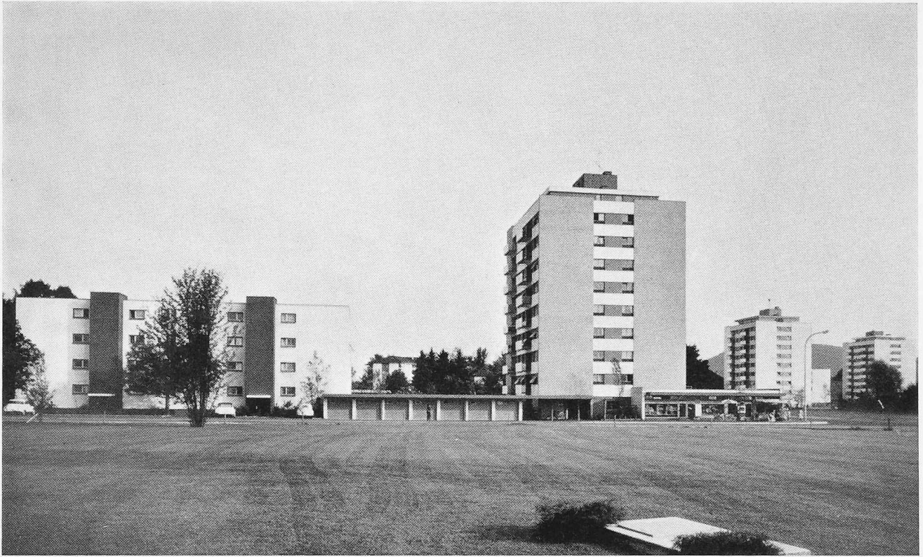
Uebersicht des Quartiers Mühlebibang aus Norden
