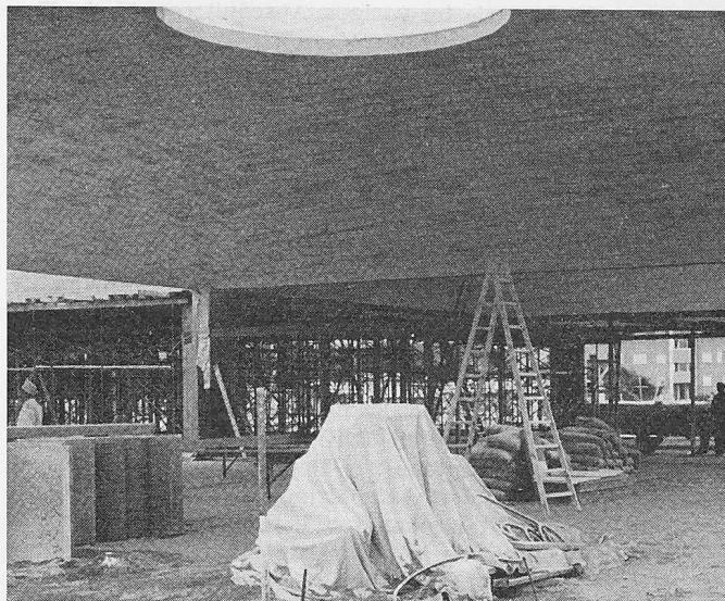
Innere der im Rohbau fertig gestellten Buckelschalen. Die Perfekta-plattenschalung ist deutlich sichtbar
