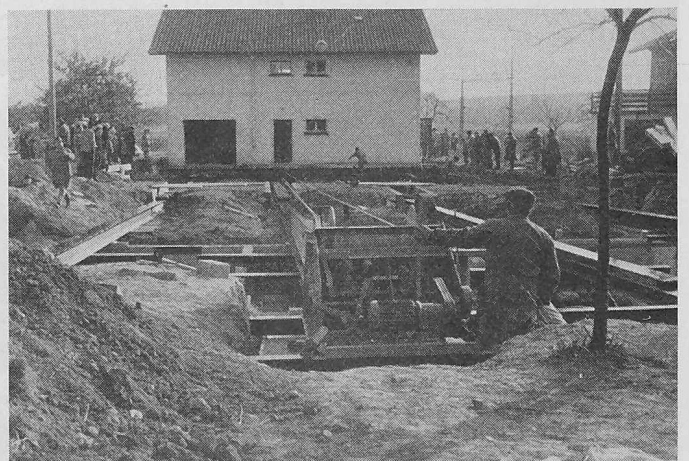
Bild 2. Nach der ersten Hälfte der Verschiebungsaktion (Vorschub um 40 m)
