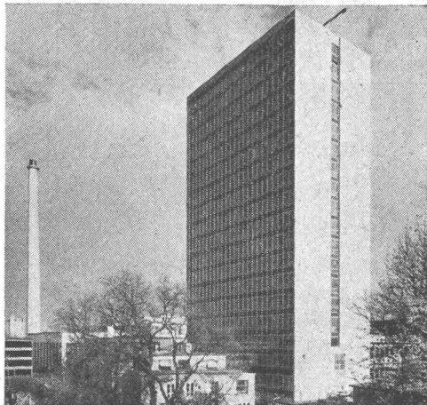
Im Hochbau für hohe Festigkeiten
